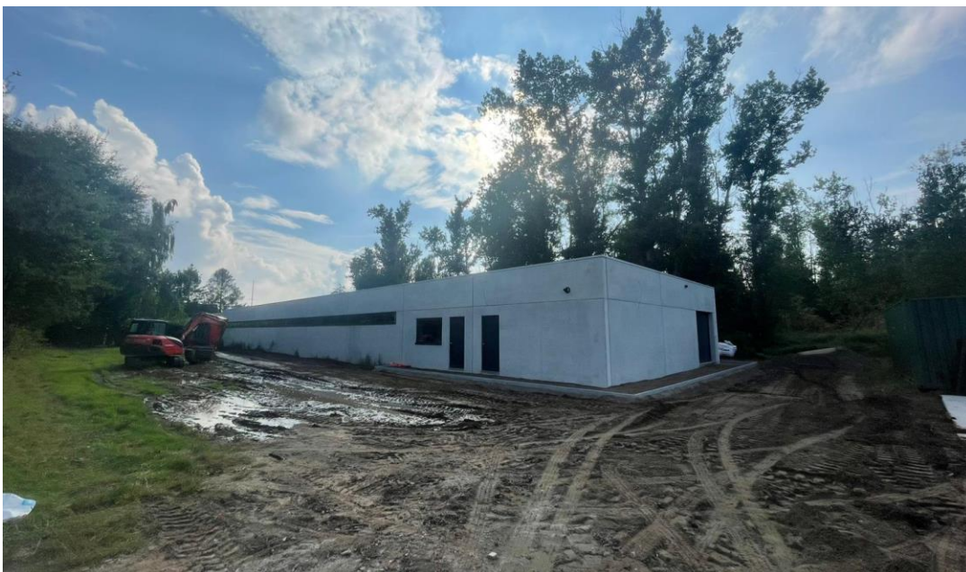
Afb. 3. Foto van de ruwbouw van het nieuwe lokaal
